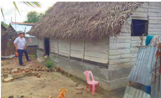
Haus mit neuem Fundament
